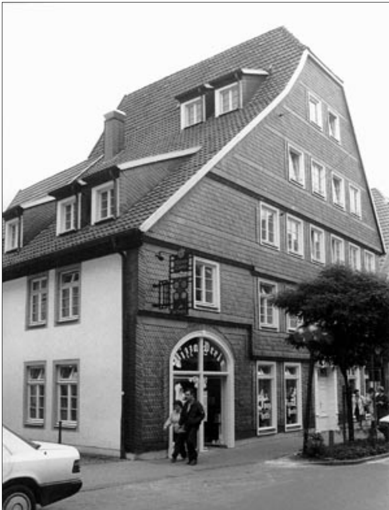
Abb. 3: Eine wegen der aufstehenden Bebauung – Dielenhaus mit eingezogenem Hinterhaus von 1552 – noch belegbar aus der Zeit vor den Stadtbränden in Lippstadt im 17. Jahrhundert stammende breite Hausstätte an der Langen Straße 5. Die Beifahrt in der Neuzeit mit einem angeschleppten Nebenhaus überbaut (Foto: Westfälisches Amt für Denkmalpflege 1988).
