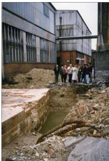
Abb. 7: Bei Beginn der Abbrucharbeiten auf dem Gießereigelände im Juli 1997 freigelegte Festungsfundamente.
