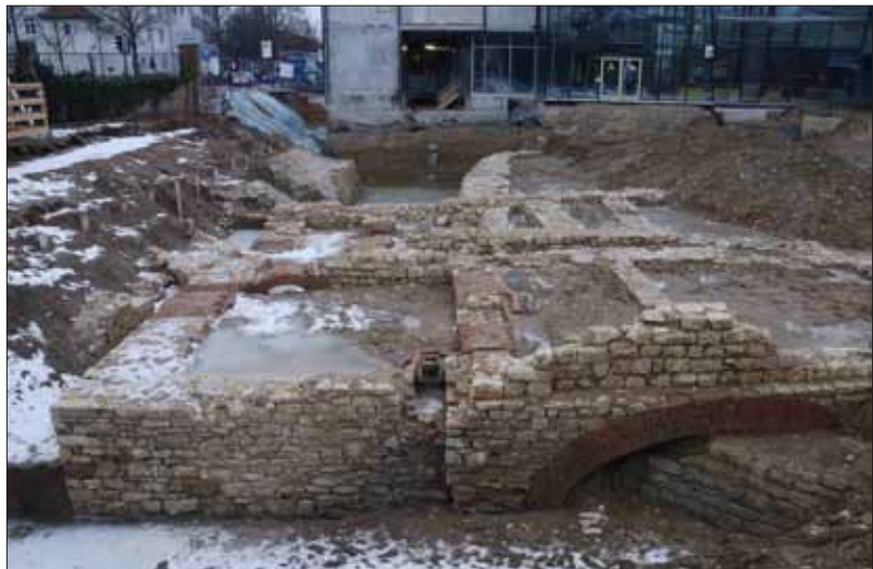
Abb. 4: Baufenster zur Erweiterung der Fachhochschule. Im Vordergrund Mauerzüge der Nutzung des 19. Jahrhunderts (sogenannte Direktorenvillen), die im westlichen Bereich in die Gräben der barockzeitlichen Anlage gründen. Die Ziegelbögen dienen der Entlastung. Im Bildhintergrund ist der Verlauf der barockzeitlichen Befestigungsmauer zu erkennen.
