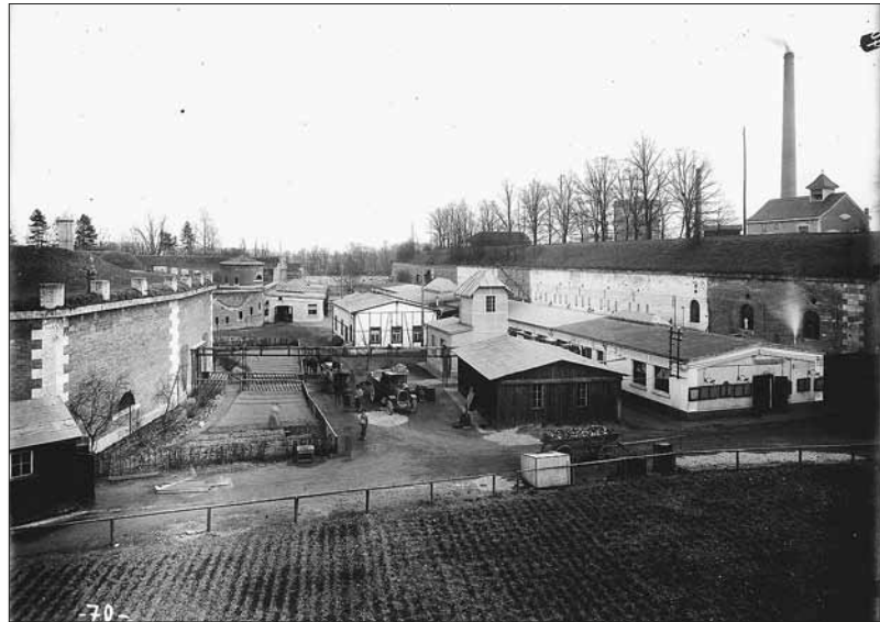
Abb. 9: Füllwerk der Kgl. Bayerischen Geschützgießerei und Geschößfabrik im Festungsgraben während des Ersten Weltkriegs. Lagerschuppen am linken Bildrand an die Batterie der Kontergarde angebaut, Schmelzhaus XXI im Hintergrund mit offenem Tor an ein Reduit angebaut, hölzerne Frühstücksbaracke in der Bildmitte, Füllwerkstätte rechts, dahinter der Hauptwall.
