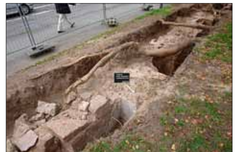
Abb. 12: Freigelegte Grundmauern der Synagoge.
