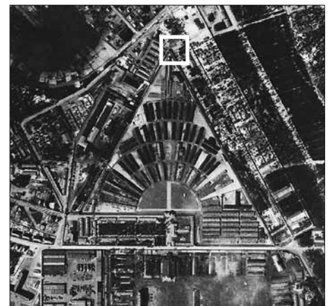
Abb. 7: Luftbild des KZ Sachsenhausen von 1943. Der Rahmen kennzeichnet die Fundstelle der Müllgrube.
