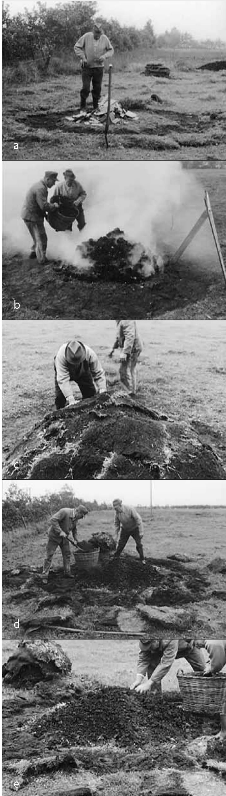
Abb. 7: Brennen von Torfkohle, Ausschnitte aus dem Film von A. Lühning (1973). a: Anlegen des Meilers und Anzünden des Holzstoßes; b: Aufschütten des Meilers mit getrockneten Torfstücken; c: Abdecken des Meilers mit Grassoden; d: Öffnen des Meilers und Entnahme der Torfkohle; e: geöffneter Meiler mit beiseitegelegten Grassoden der Meilerabdeckung.
