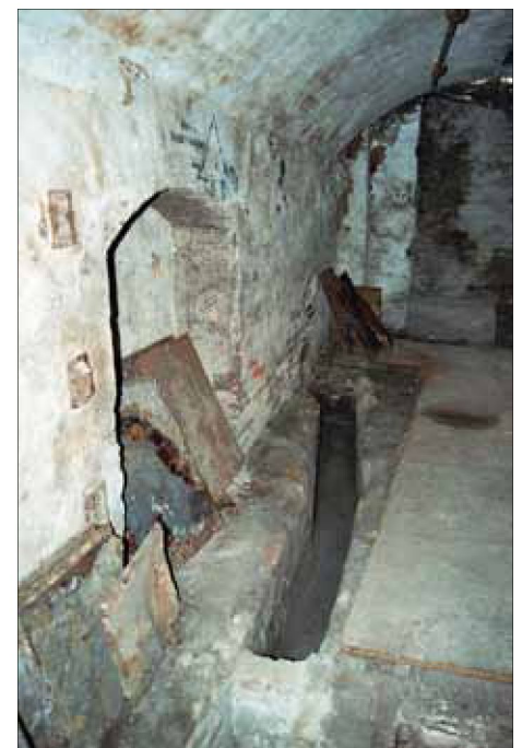
▽ Abb. 7: Hüttenwerk Lauchertal, Schlackenabstichgrube des Hochofens.
