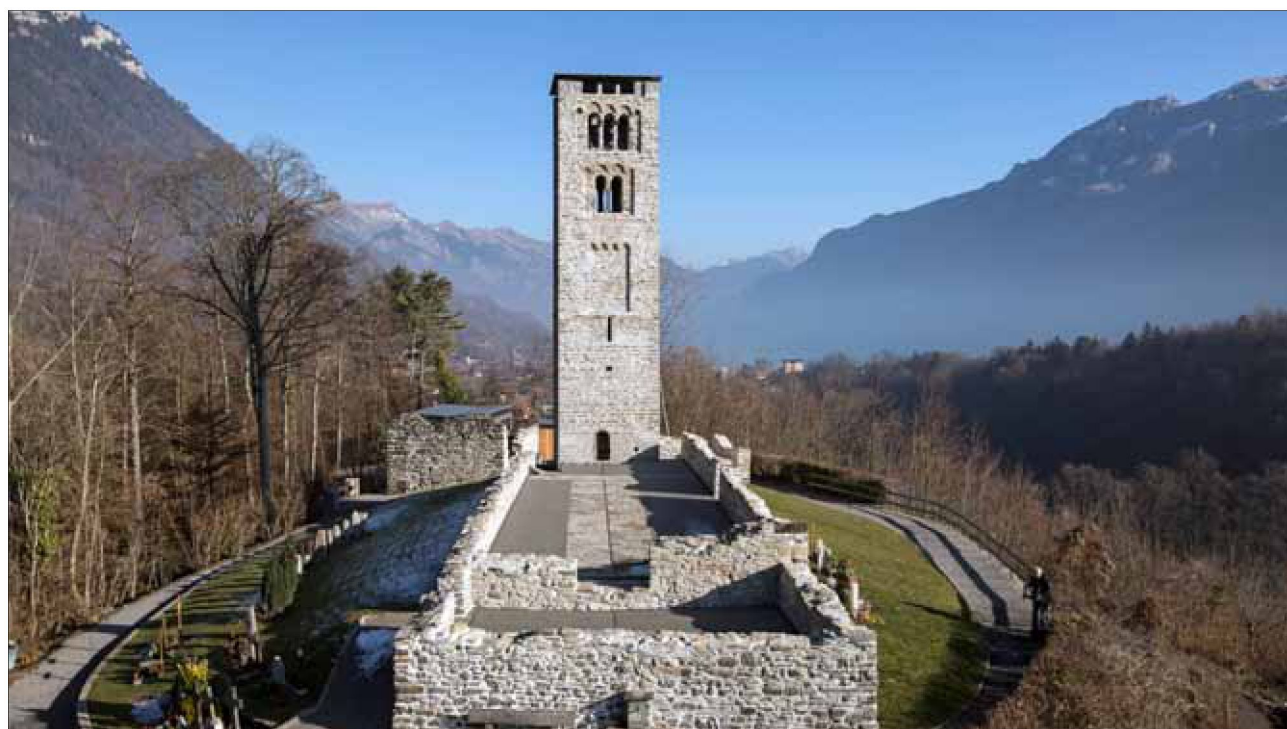
Abb. 1: Kirchenruine Goldswil nach der Sanierung 2016, Blick nach Osten.
