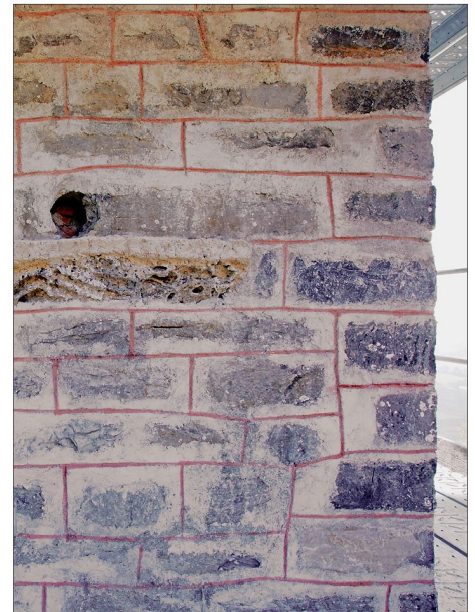
2: Pietra-rasa-Putz mit rot gefasstem Fugenstrich an der Nordseite des Goldswiler Glockenturms nach der Sanierung 2015.
