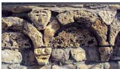
Abb. 10: Auf der Südseite des Campanile zwischen den Blendbögen des oberen Schallgeschosses eingefügte romanische Maskenzier.
