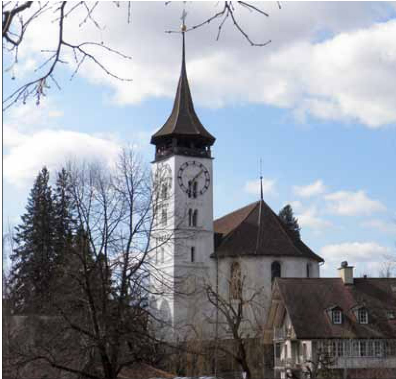
Abb. 11: Ostchor der Kirche von Steffisburg mit dem vermutlich romanischen Glockenturm 2012.
