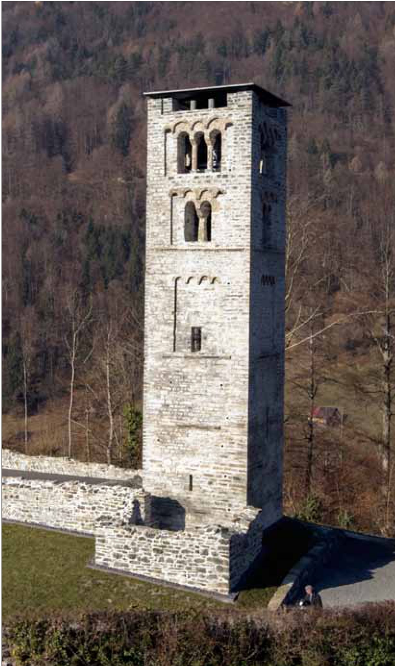
Abb. 9: Südansicht des Campanile mit Teilen der Kirchenruine St. Peter nach der Sanierung 2016.
