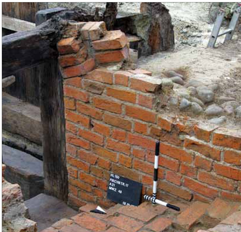
Abb. 5: Backsteinschale der westlichen Seitenwand an der Treppe Fischstraße 15–17. Man erkennt hier exemplarisch die qualitätvollen Backsteine sowie die perfekte Ausführung des Mauerwerks.
