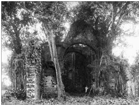
Abb. 2: Die überwucherten Ruinen der Kirche von Las Monjas de Nuestra Señora de la Concepción im Jahr 1912. Der Konvent liegt zwischen dem Hospital San Juan de Dios und dem hier vorgestellten Gebäudekomplex.
