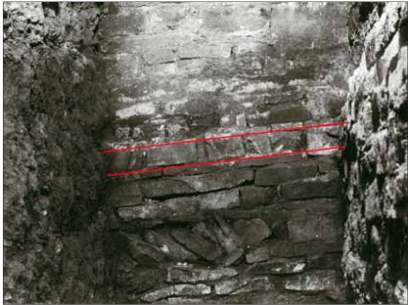
Abb. 15: Grabung 1956. Nordwand des nördlichen Querhausarms, Blick von Süden. Die beiden Linien markieren den Übergang vom Fundament zum Aufgehenden.
