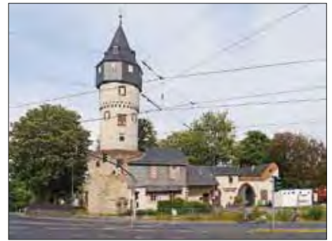
Abb. 8: Bornheim, Frankfurt am Main. Friedberger Warte am Durchgang der Friedberger Landstraße durch die Frankfurter Landwehr. Der rechteckige Wehrhof ist mit einem Butterfass-turm gesichert, dessen unterer Teil Schlüssel-scharten aufweist.
