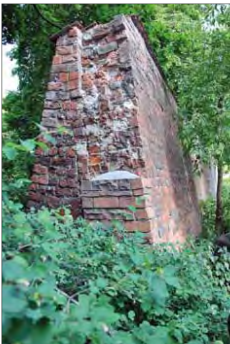
Abb. 14: Wollenweberstraße. Blick auf die Abbruchkante der Stadtmauer.
