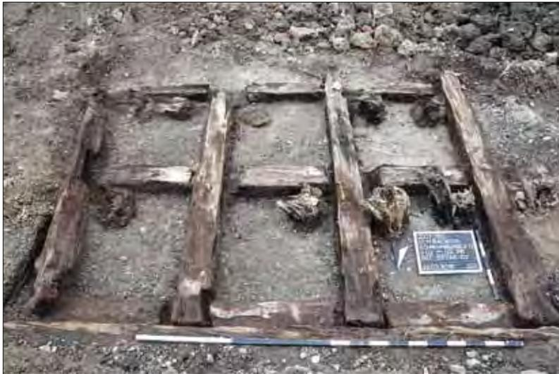
Abb. 16: Hölzerne Substruktion unter der Wallmauer der Bleichbastion mit drei Längsbalken sowie Rammpfählen in den Zwischenräumen.
