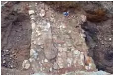
Abb. 14: Abgerutschte Backsteinmauer des Geschützwalls.
