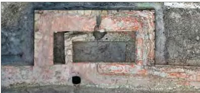
Abb. 13: Auf einem 3-D-Modell basierte Ansicht der Befestigungsmauer im Bereich Olgastraße 66 mit der vorspringenden Streichwehre aus dem 16. Jahrhundert innerhalb des Pulverturms des 17. Jahrhunderts.
