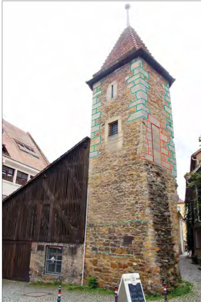
Abb. 5: Der Kesselsturm mit angelehntem Zeughaus, welches das Zwingerareal überspannt. Mit nachgezeichnetem auffälligen Mauerwerkwechsel und Türsetzung zum Wehrgang.
