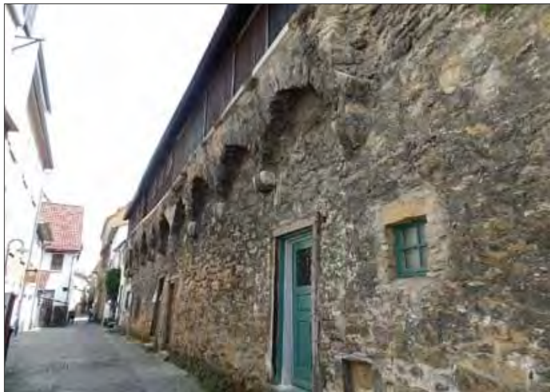
Abb. 8: Heutige Mauerhäuser in der Jos-Weiß-Straße. Sie wurden in den Zwingerbereich gebaut und die Mauer für Türen und Fenster und zur Raumerweiterung regelrecht ausgehöhlt.
