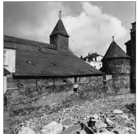
Abb. 6: 1982 freigelegte stadtsseitige Zwingermauer mit Zwingerturm, im Hintergrund der Kesselmauerturm. Den Zwinger überspannt an dieser Stelle ein Zeughaus von 1546 i.
