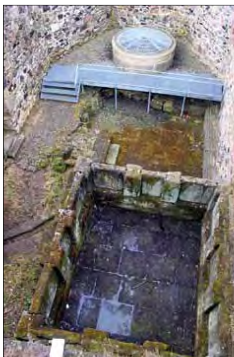
Abb. 20: Heutiger Zustand des Brunnenhauses mit Zisterne und Brunnen.
