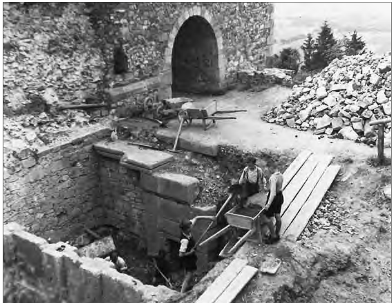
Abb. 4: Teilweise freigelegtes Brunnenhaus. Vorne links: Zisterne; Mitte: ehemaliger Zugang; hinten: neu errichteter Torturm.
