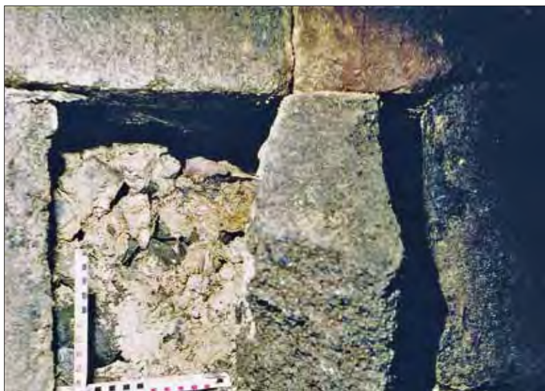
Abb. 16: Hohlraumverfüllung zwischen gewachsenem Fels und Brunnenwandung mit Basaltbruch und Mörtel.
