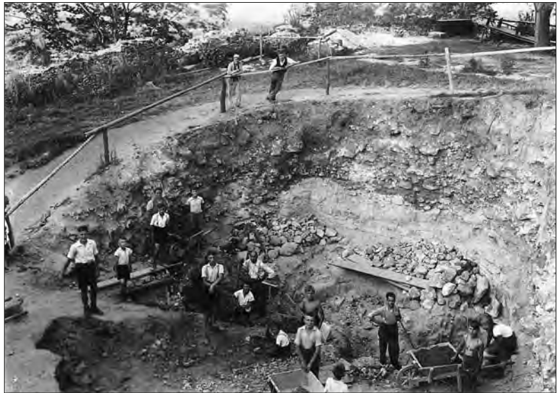
Abb. 3: Ausgrabungsarbeiten im Brunnenhaus 1938.
