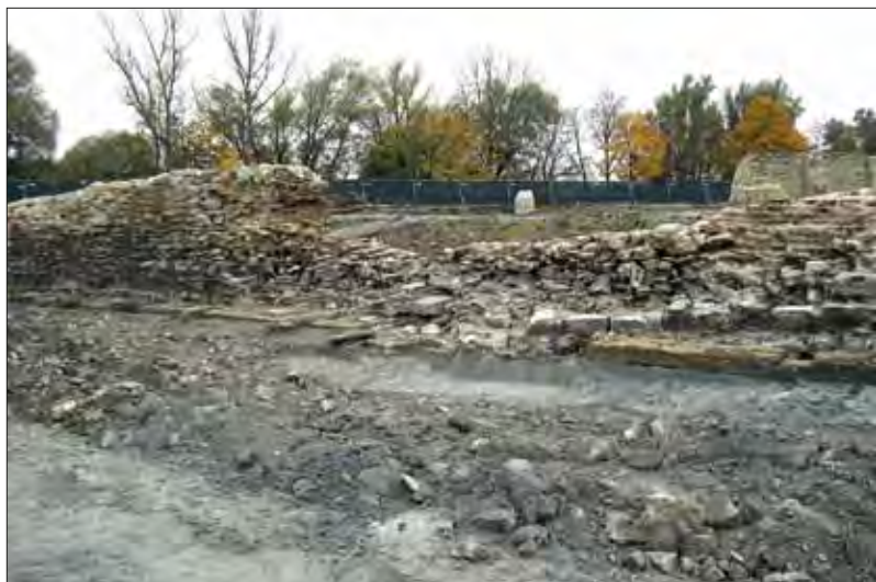
Abb. 7: Gießereigelände. Blick nach Südwesten. Durch Sprengung deformierte aufgehende Mauerpartien und verschobene hölzerne Mauersubstruktionen.
