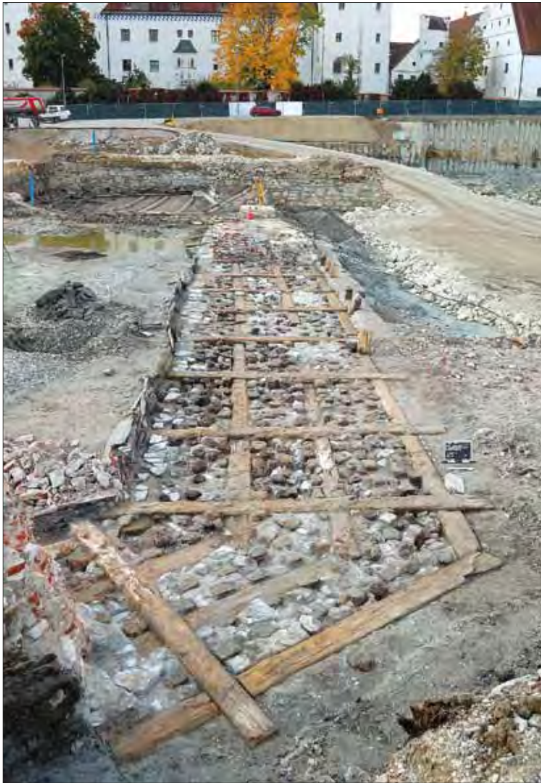
Abb. 5: Gießereigelände. Blick nach Westen. Detail der hölzernen Substruktionen der Festungsmauern.
