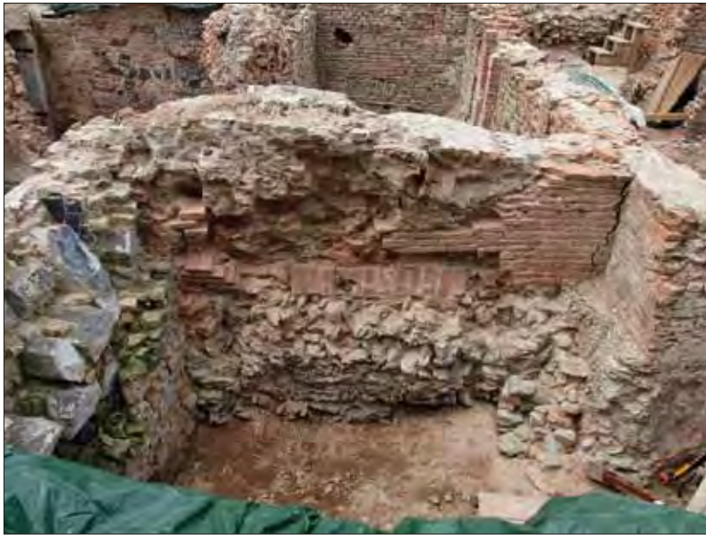
Abb. 3: Im Mittelalter angelegte Latrine, die teilweise auf römischen Mauerresten errichtet wurde. Vermutlich handelt es sich um die in den Schriftquellen erwähnte und gemeinschaftlich von Juden und Christen genutzte Latrine. Sie weist auf der Südseite (links) eine mit Schieferplatten verlegte Einfüllrutsche auf, die in Verbindung mit dem christlichen Grundstück Bardowick stand. Eine Einfüllrutsche von der Judengasse ist nicht mehr erhalten. Das liegt vermutlich an der starken Überprägung der Latrinenmauer an der Ostseite. Blickrichtung nach Westen.
