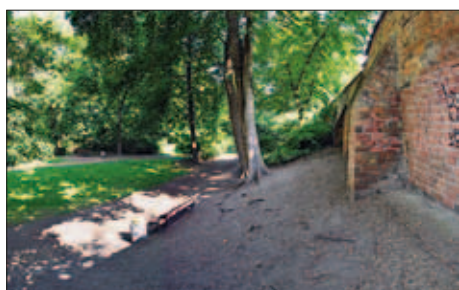
Abb. 17: Brandenburg, Neustadt. Stadtmauer an der Wollenweberstraße.
