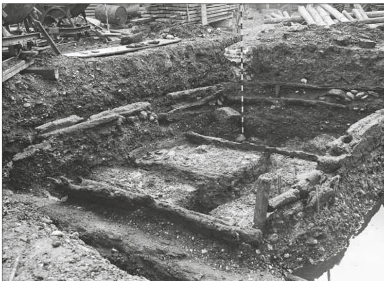
Abb. 1: Gesamtaufnahme Bau II (nach Berger 1963) in Richtung Südsüdost (1937).
