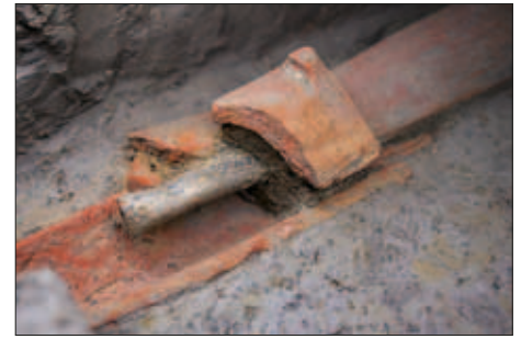
Abb. 8: Detailaufnahme der mit Dachziegeln ummantelten Bleileitung.
