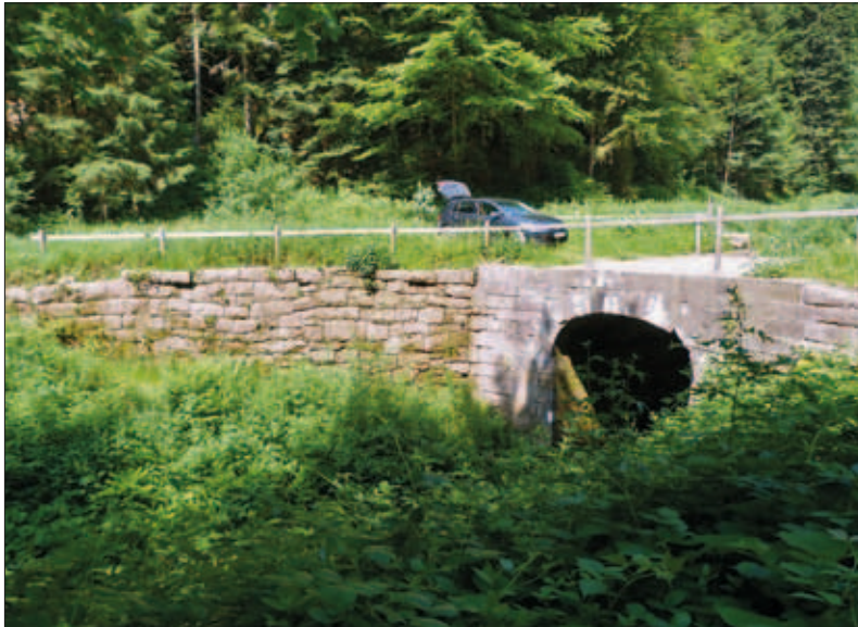
Abb. 3: Schenkzell-Kaltbrunn, Flößereiwehr „Untere Lay“.
