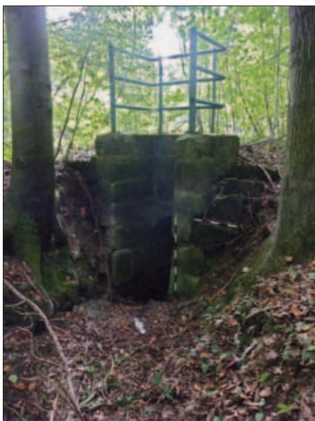
Abb. 4: Die Wasserwege nordöstlich von Klosterlangheim führen von den Quellfassungen über Kanäle; das Wasser wird anschließend in Teichen gesammelt und weiter über ein Stollenmundloch in den Untergrund eingeleitet.
