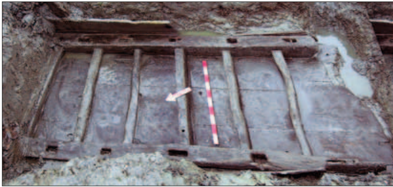
Abb. 9: Seriem bei Neuharlingsiel, Landkreis Wittmund. Kastensiel wohl aus der Zeit vor 1570.
