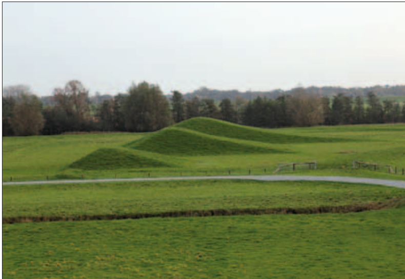
Abb. 5: Dangast, Stadt Varel, Landkreis Friesland. Im Jahr 2000 rekonstruierte Deichprofile des 11. bis frühen 20. Jahrhunderts.
