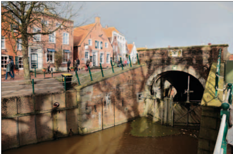
Abb. 10: Altes Greetmer Siel in Greetsiel von 1674 mit Umbauten von 1798, Binnenseite. Gewölbesiel mit einer Weite von 4,85 m bei einer Höhe von 5,75 m. Zustand 2017.
