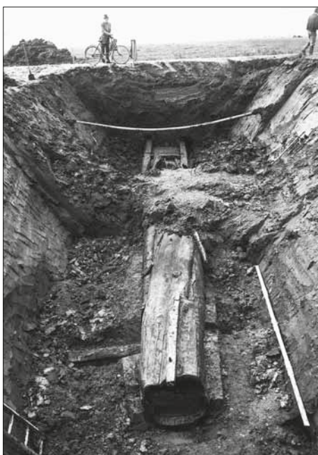
Abb. 7 und 8: Stollhammer Ahndeich, Gemeinde Butjadingen, Landkreis Wesermarsch. Holzernes Klappsiegel des 14. Jahrhunderts, Foto und Zeichnung.
