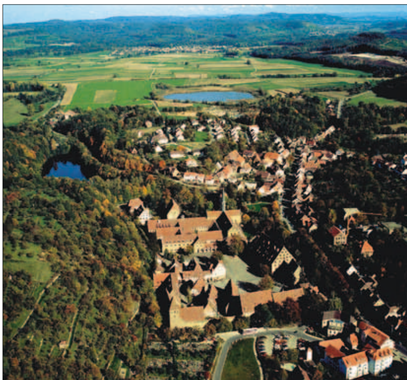
Abb. 1: Maulbronn, Luftansicht des Klosters von Westen. Links ist der Tiefe See, im Mittelgrund der Roßweiher und im Hintergrund der Höhenzug des Strombergs zu erkennen.
