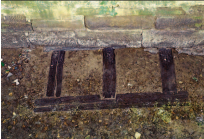
Abb. 12: Die von einer Wange des Kollmarsreuter Mühlkanals überbaute Holzkonstruktion in Emmendingen belegt mindestens zwei Bauphasen, die jedoch noch nicht datiert werden können.
