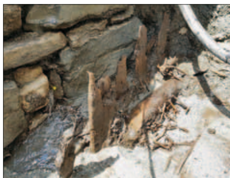
△ Abb. 11: Detail der Pfahlreihe und der horizontal verlegten Tännchen vor der nordöstlichen Piermauer des nordöstlichen Piers. Die Baumwipfel waren durch ihre Äste mit den flachen Schwirren verhakt.
