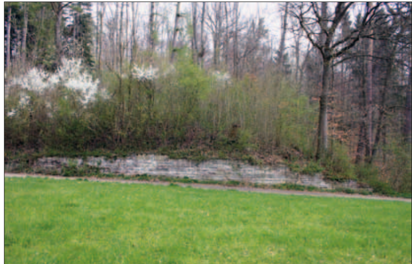
Abb. 6: Der Durchstich durch die südliche Dreiecksbegrenzung zeigt das Profil des auch hier modellierten Walls an der Talseite.
