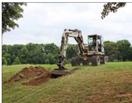
4 Sondageschnitt (Fläche 2) am mutmaßlichen Stadtwall der postulierten ursprünglichen Stadtgründung in Form eines Rundlings.
