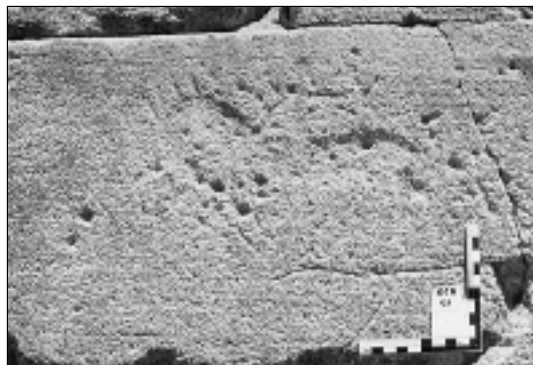
Abb. 10: Dasselbe Graffito im Frühjahr 1995 verdeutlicht die Zerstörungskraft sandhaltiger Windwirbel im Lee von Hindernissen, (Foto: P. Wolf).
