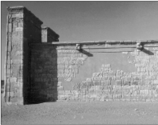
Abb. 6: Nördliche Außenwand des Apedemak-Tempels 1993. Hier hat sich in den vergangenen 24 Jahren keine Echodüne herausgebildet (Foto: P. Wolf).
