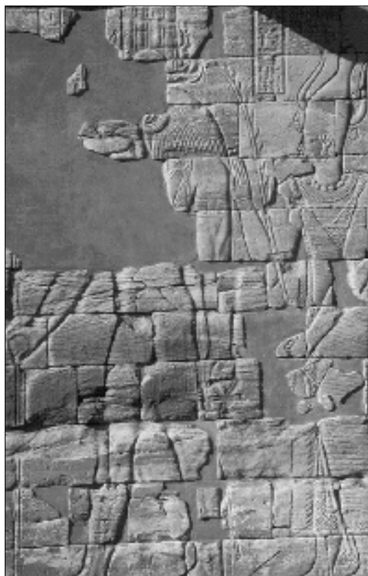
Abb. 7: Detail von Abb. 6. Die untere Wandpartie war schon vor dem Wiederaufbau des Tempels der Verwitterung ausgesetzt. Die tiefen Aussprengungen in Höhe der Oberschenkel des Amun markieren die Oberkante einer ehemaligen Echodüne. Hier wirkten Salzdruckverwitterung und Korrasion besonders stark. Die höheren Mauerpartien mit leichteren Korrasionschäden durch Staubwind sind erst seit der Rekonstruktion der Verwitterung ausgesetzt (Foto: P. Wolf).
