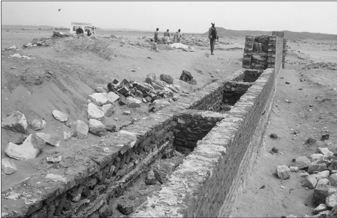
Abb. 10: Konstruktion der neuen Umfassungsmauer in Zweischalenbauweise (Neg.Nr. 1199-30)
