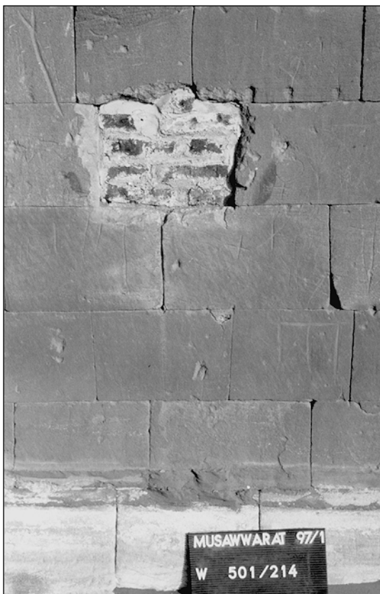
Abb. 5: Zugemauerter Mauerausbruch in der Wand 501/214 (Neg.Nr. 1259-17)
