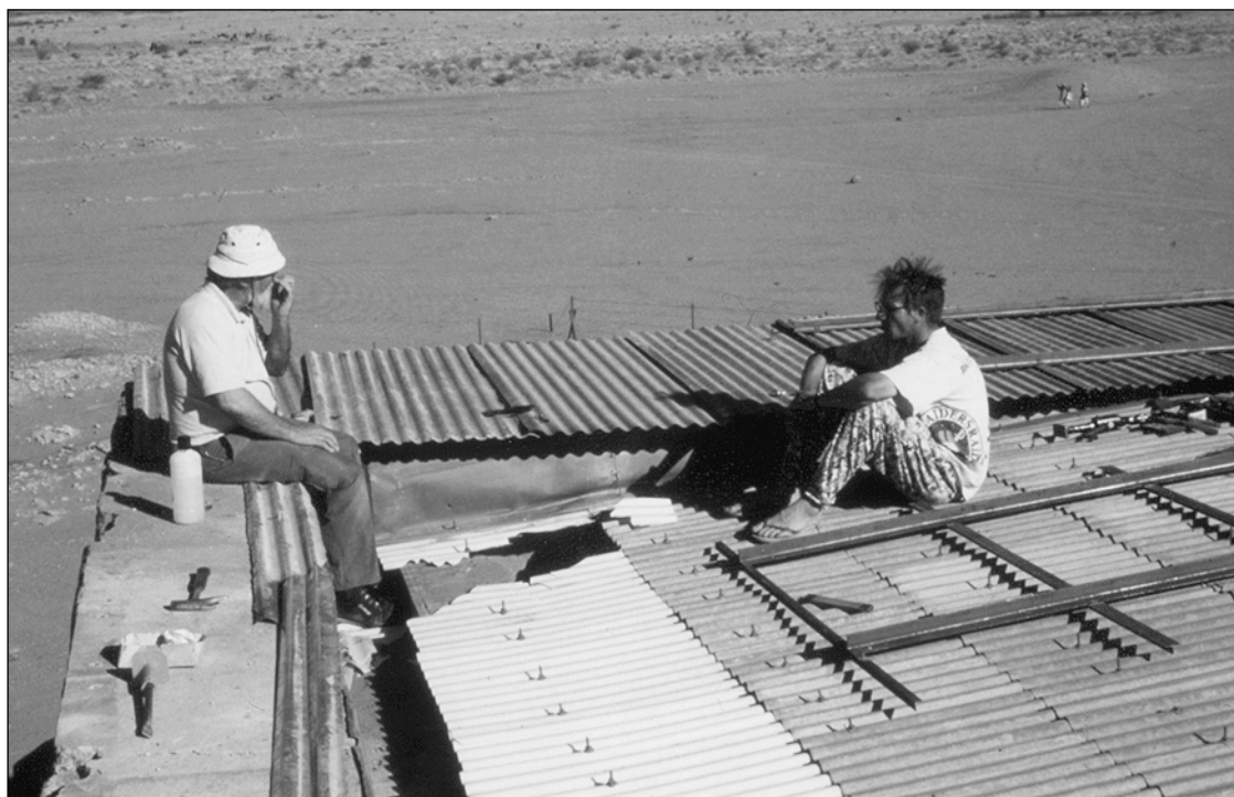
Abb. 1: Erste Reparaturarbeiten am Dach des Löwentempels 1995
