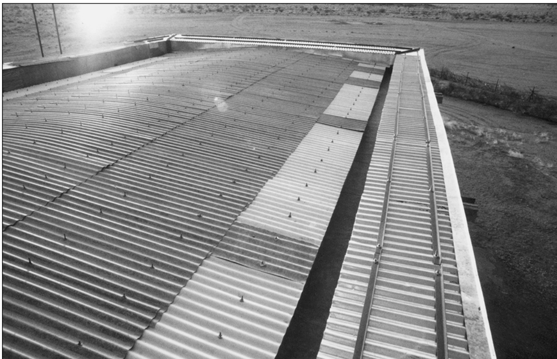
Abb. 2: Der neu eingedeckte Dachkranz des Löwentempels (Neg.Nr. 1229-28)
