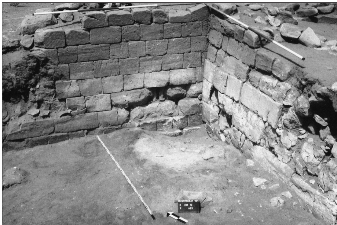
Abb. 9: Ausbrüche in den Wänden 224/N und 224/226, die wahrscheinlich durch Hitzeeinwirkung entstanden sind (Neg. Nr. 1218/25)
