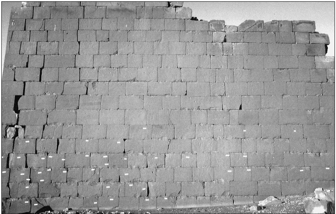
Abb. 4: Wand 529/525S während der Dokumentation der Sekundärbilder. Derartige Überblicksbilder verdeutlichen auch die mengenmäßige Verteilung der Graffiti.
