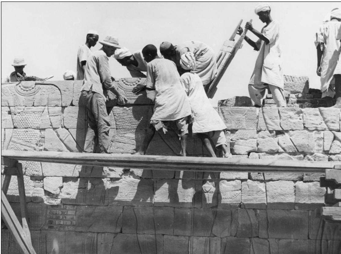
Abb. 1: Beim Wiederaufbau der Südwand des Löwentempels
