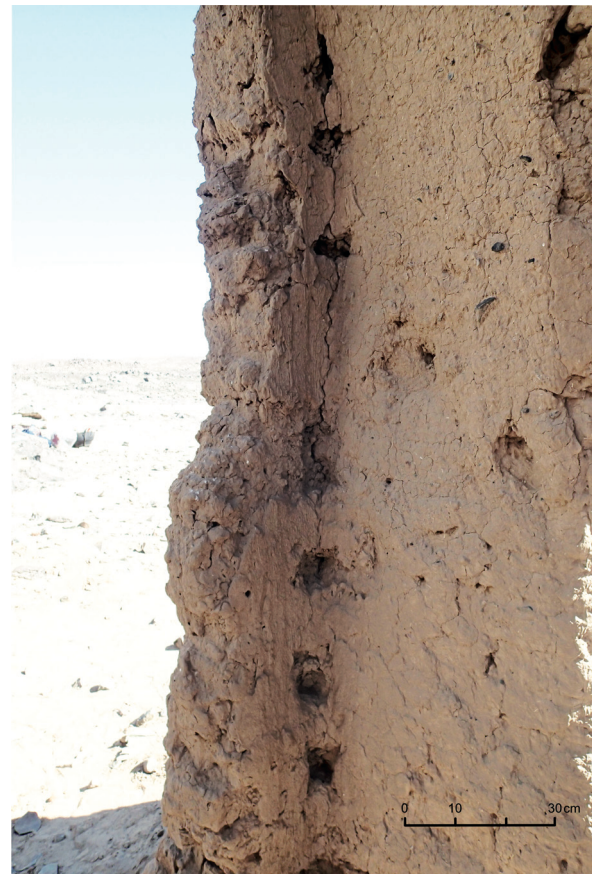
Abb. 13: Detail der Pfostenabdrücke auf der Innenseite des Ostpfeilers des Kuppelbaus. Foto: C. Geiger, © MUAFS.
