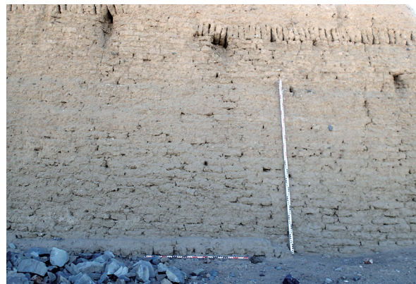
Abb. 4: Ansicht der Westmauer mit der hochkant verbauten Ziegellage und dem zusätzlichen Ziegelanbau an der Mauer- sohle. Foto: J. Distefano, © MUAFS.
