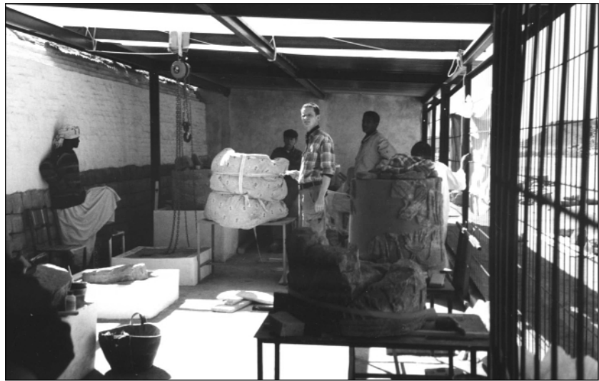
Abb. 2: Errichtung der Säulen mit Hilfe eines Flaschenzuges im Südflügel des Museums.
