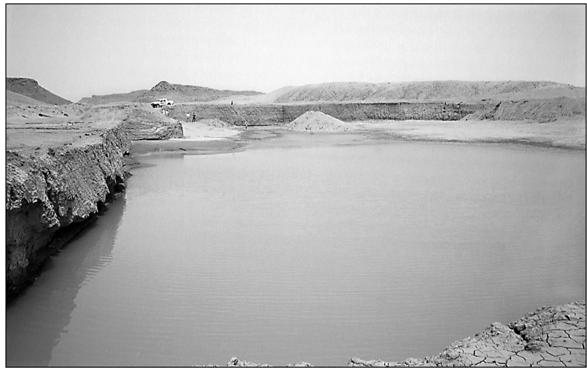
Abb. 11: Starke Unterspülungen durch das in die Abbaggerungsfläche eingeströmte Regenwasser, die zum Einstürzen der Wandung führen. Links das begonnene Längsprofil entlang der Hafirmittellachse (Foto: Zaroug Bakri Mohamed Ahmed, Inspektor NCAM).
