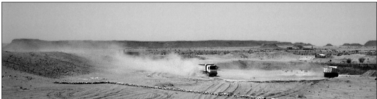
Abb. 9: Permanente Sand- und Staubauswehungen in Richtung Löwentempel durch die Reaktivierung der Hafirsedimente infolge Ausbaggerung und Befahrung.
