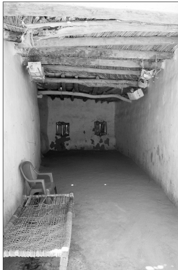
Abb. 13: „Sala“ des Hassan Mohammed Idris (Abb. 11 – Raum 8), Blick gegen Süden. Um dem kühlenden Nordwind Zutritt zu gewähren besitzt der Raum keine Wand gegen Norden. Die Fenster in der Südwand dienen zur Regulierung des Luftzuges. Die von der Decke abgehängten Behälter dienen als Niststätten für Tauben. Im Raum zwei typische Möbelstücke, die heute am 4. Katarakt in Gebrauch sind: „angarib“ und Plastikstuhl.
