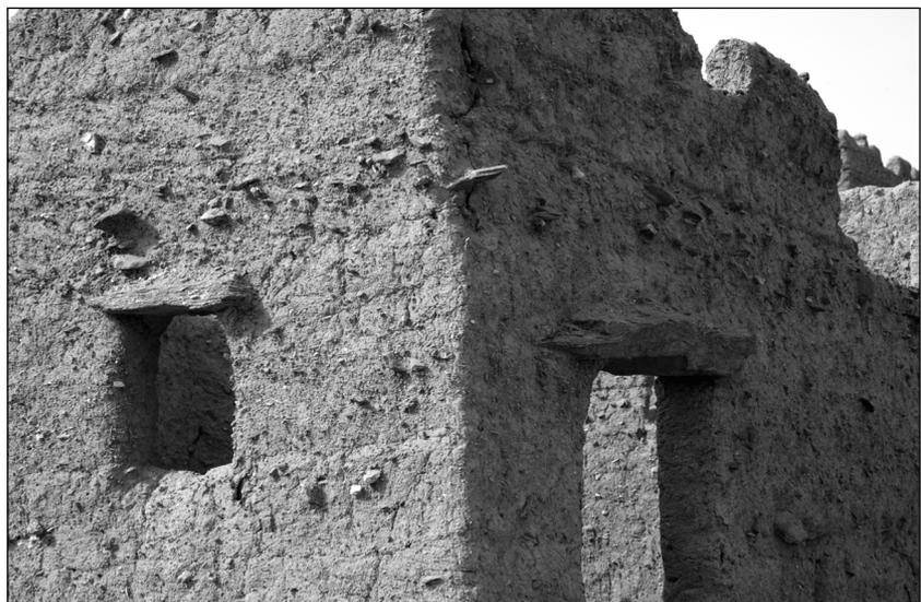
Abb. 4: Rechteckiges Gebäude aus Stampflehm mit hohem Steinanteil; Steinplatten über Fenster und Tür: Koranschule in Alt-Atoyah.
