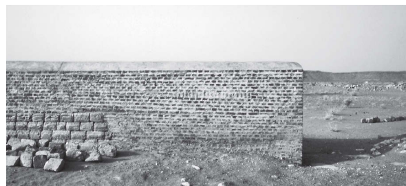
Abb. 14 Westl. Mauerende 305/415 vor dem Rückbau von N
