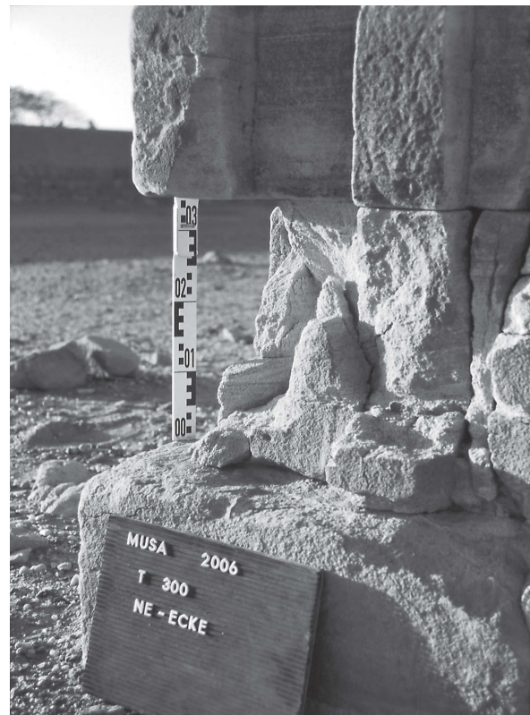
Abb. 46 Tempel 300, NE-Ecke vorher
