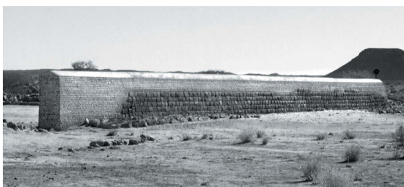
Abb. 13 M 305/415 vor dem Rückbau von SW
