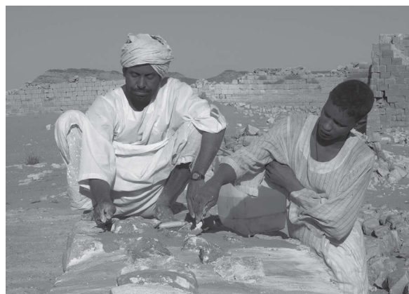
Abb. 17 Versiegeln der Mauer(füllung) mit Kalkmörtel
