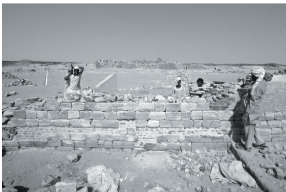
Abb. 23 Nordende der M 305/E im Robbau
