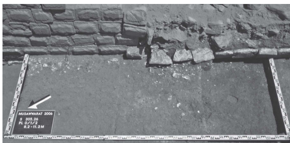
Abb. 31 Planum mit aus der Fassadenflucht ziehender 2. Blocklage (Mitte bis rechts) in der Wand 305/E. Links davon die reparierte Mauerflucht mit Bossenblöcken
