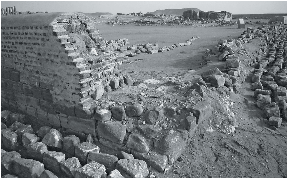
Abb. 18 Zustand der M 305/E vor Beginn der Arbeiten. Blick nach N auf die SE-Ecke des Hofes 305
