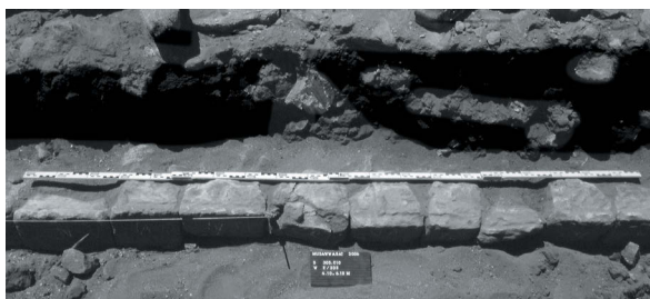
Abb. 33 Risslinie auf der originalen 1. Lage außen
