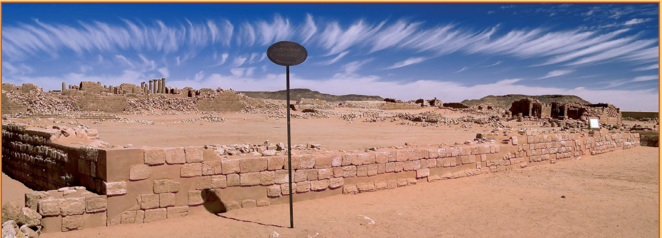
Farbabb. 16 Gesamtansicht fertige Mauer 305/E von SE
