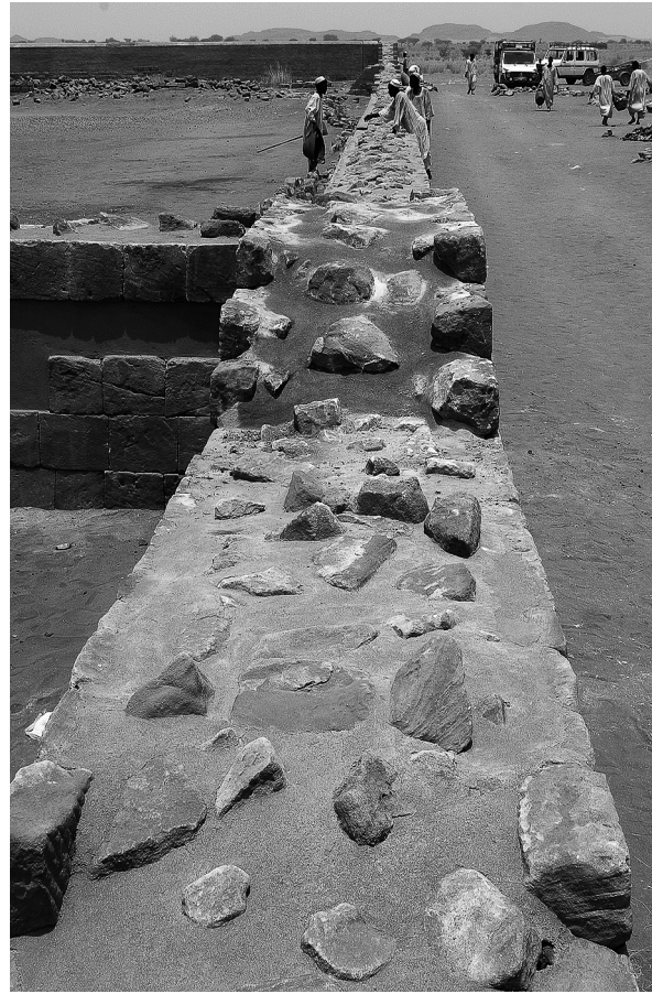
Abb. 3b: Ansicht nach Abschluss der Arbeiten 2008. Vorn die neu gestaltete Ecke der Mauern 304+305/E und 304/305 (s. u. im Text).
