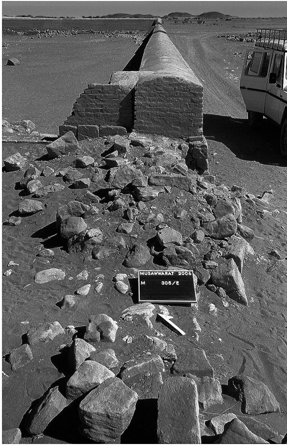
Abb. 3a: Der Zustand der östlichen Umfassungsmauer im Bereich der Höfe 305+304+307 (Abfolge v. vorn n. hinten) vor dem Beginn ihrer Neugestaltung seit 2006.
