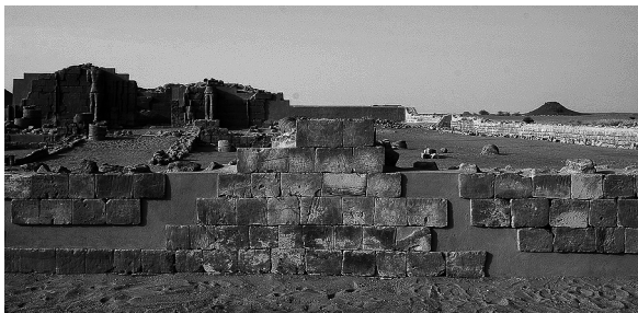
Abb. 14: Derselbe Wandabschnitt nach seiner originalgetreuen Rekonstruktion aus den sechs en-bloc verstürzten Lagen.
