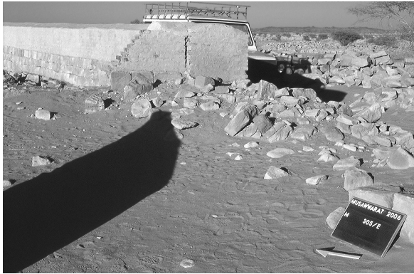
Abb. 19: Die NE-Ecke des Hofes 305 vor Einführung der neuen Restaurierungskonzeption in der Kampagne 2006.
