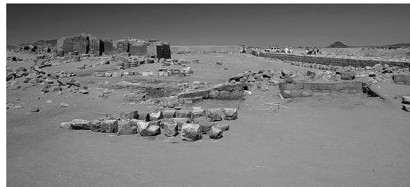
Abb. 11b: Derselbe Abschnitt während der Freilegungsarbeiten ...
