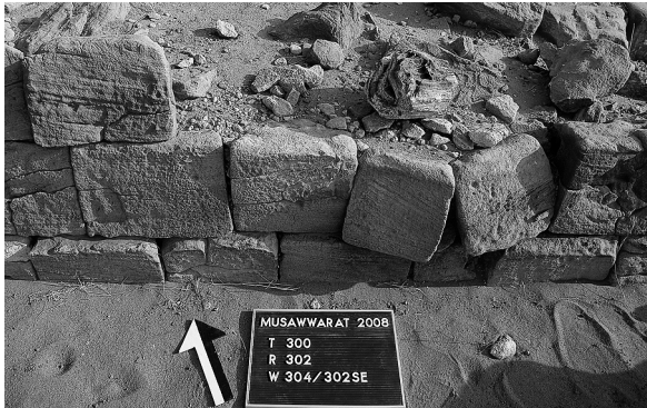
Abb. 5: Verkippte Blöcke in der südlichen Außenwand des Vorbaus von T 300 zu Beginn der Kampagne.
