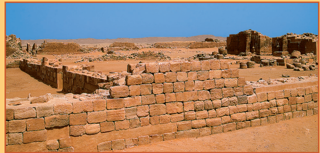
Farbabb. 10: Ansicht dieses Areals nach Abschluss der Sanierungs-, restauratorischen Wiederherstellungs- und Neugestaltungsarbeiten der Kampagnen 2006-2008.
