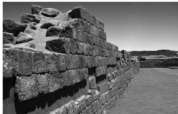
Abb. 12 a, b: Die einwärts geneigte Südfassade (Wand 304/307) nach der Freilegung und nach ihrem Wiederaufbau.
