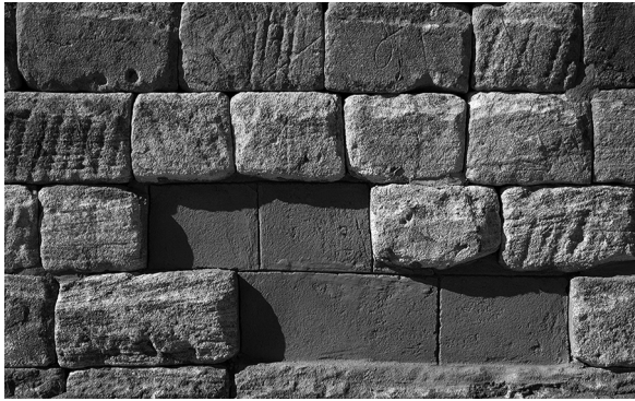
Abb. 25: Ausschnitt der Wand 307/304 mit Kennzeichnung der originalen Position und Abmessung nicht wieder verwendbarer Versturzböcke.
