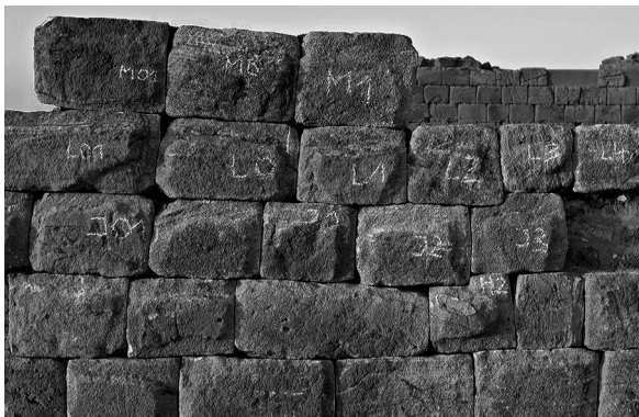
Abb. 21, 22: Originalgetreu rekonstruierte Reparaturzonen in der Wand 307/304.
