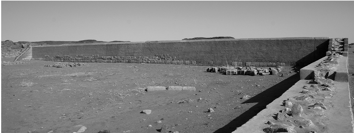
Abb. 1: Die Mauer 307/N zu Beginn der Kampagne.
