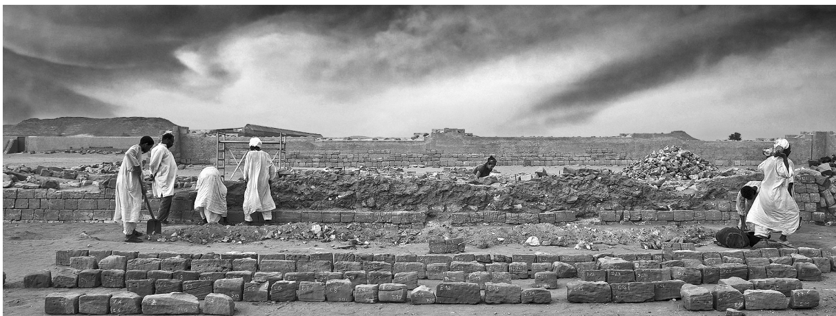
Abb. 14: Beginnende Wiedererrichtung nach dem Abtragen der Südfassade von Mauer 304/307.
