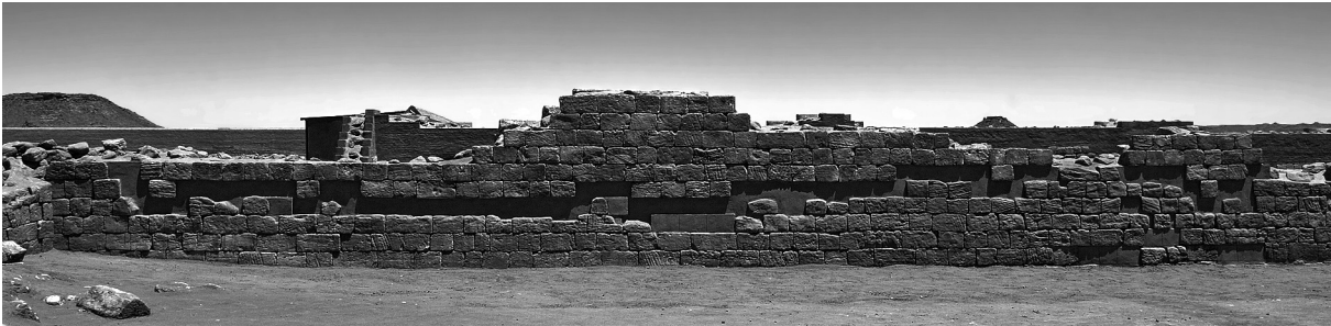
Abb. 23: Der westliche Abschnitt der Südfassade 304/307 in entsprechend der originalgetreu rekonstruierbaren Nordfassade wieder errichteter Höhe.
