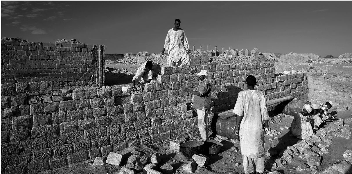
Abb. 24: Wiedereinbau von Blocklagen der Nordfassade direkt aus ihrer Versturzlage.
