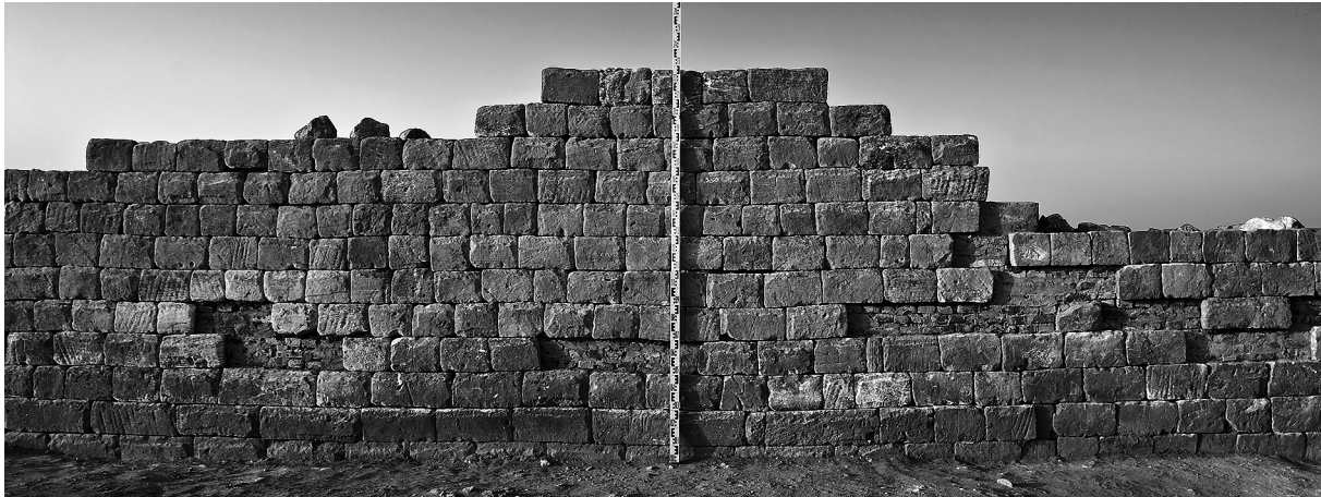
Abb. 19: Der Abschnitt der Wand 307/304 nach der originalgetreuen Rekonstruktion von 11 Blocklagen aus dem Versturzmateral (Situation vor der Wiederververfüllung des Schnittes).
