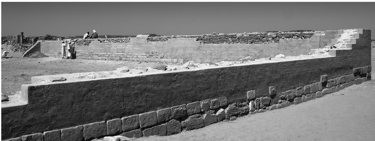
Abb. 2: Gestufter Rückbau der Ziegellagen entlang der angebrachten Markierungen.
