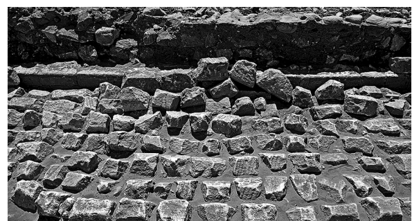
Abb. 18 a, b: Derselbe Bereich nach begonnener Beräumung der nicht in Originalposition wieder verwendbaren Blöcke sowie nach der Freilegung des erhaltenen Mauerverlaufes mit dem direkten Anschluss des Versturzes an die noch stehende Bausubstanz.
