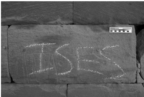
Abb. 6: Neue Besucherinschrift auf der Wand 301W/304 im Tempel 300, Februar 2009 (Foto: C. Kleinitz).
