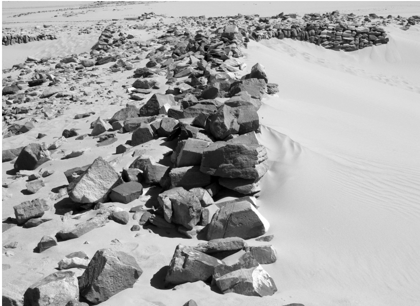
Abb. 10: Rest einer Brustwehr auf der Südmauer.
