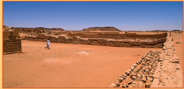
Farbabb. 12: ... und nach Abschluss der Arbeiten.
