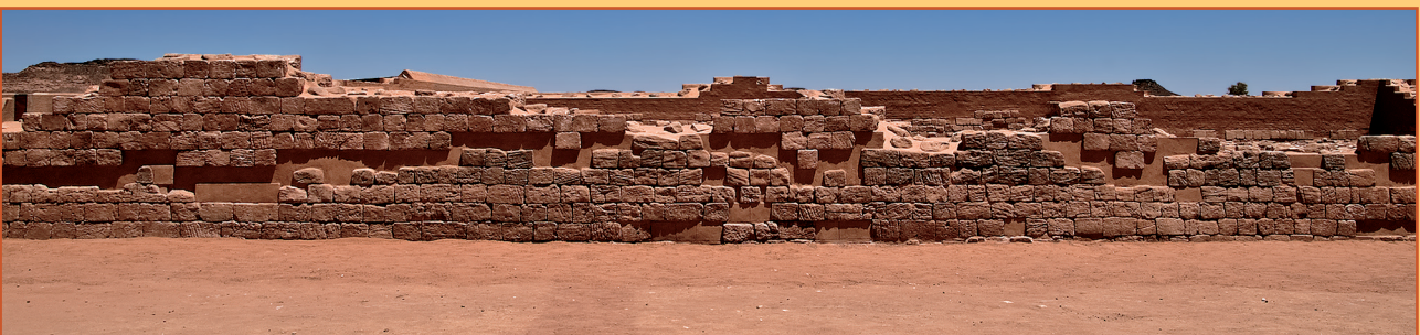
Farbabb. 14: Ansicht der Mauern 304/307 und 307/N nach Beendigung der Restaurierungsarbeiten.
