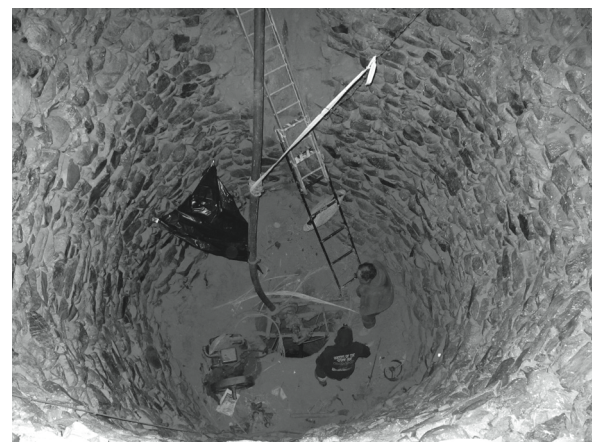
Abb. 12: Einfassungsstein-Beprobung in Brunnen B
