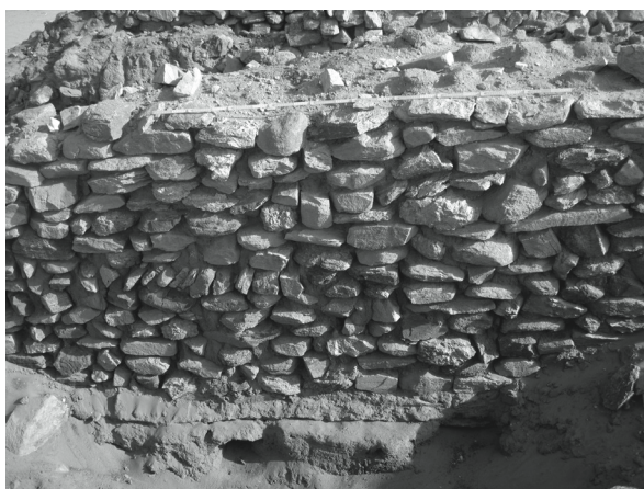
Abb. 8: Nordprofil der Sondage S1 in Raum 3.2. Die Mauer zwischen Raum 3.2 und 3.3 ist noch bis zu einer Höhe von 1,60 m erhalten. Material sind überwiegend plattige Gneisbrocken, die in Lehmörtel versetzt wurden. Die Verputzschicht ist erodiert, doch die „Verputznase“ am Mauerfuß ist noch erhalten. Sie ruht auf einem stark verfestigten grauen Begehungshorizont, auf dem auch das Mauerwerk sitzt. Darunter eine Kulturschicht mit lockerem Erdmaterial. Der Befund stimmt in hohem Maß mit dem Befund von Sondage S3 (Abb. 6) überein. (Foto: D. Eigner).
