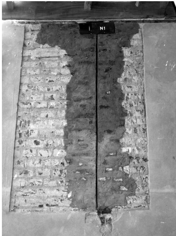
Abb. 3: Auflager N1 nach Einbau des Widerlagers und Schließen des Schlitzes mit Mauerwerk (Foto: Peter Becker)
