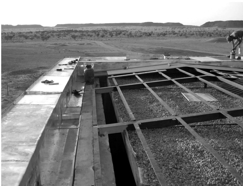
Abb. 5: Montage der Rinne und der Attika-Abdeckungen (Foto: Peter Becker)
