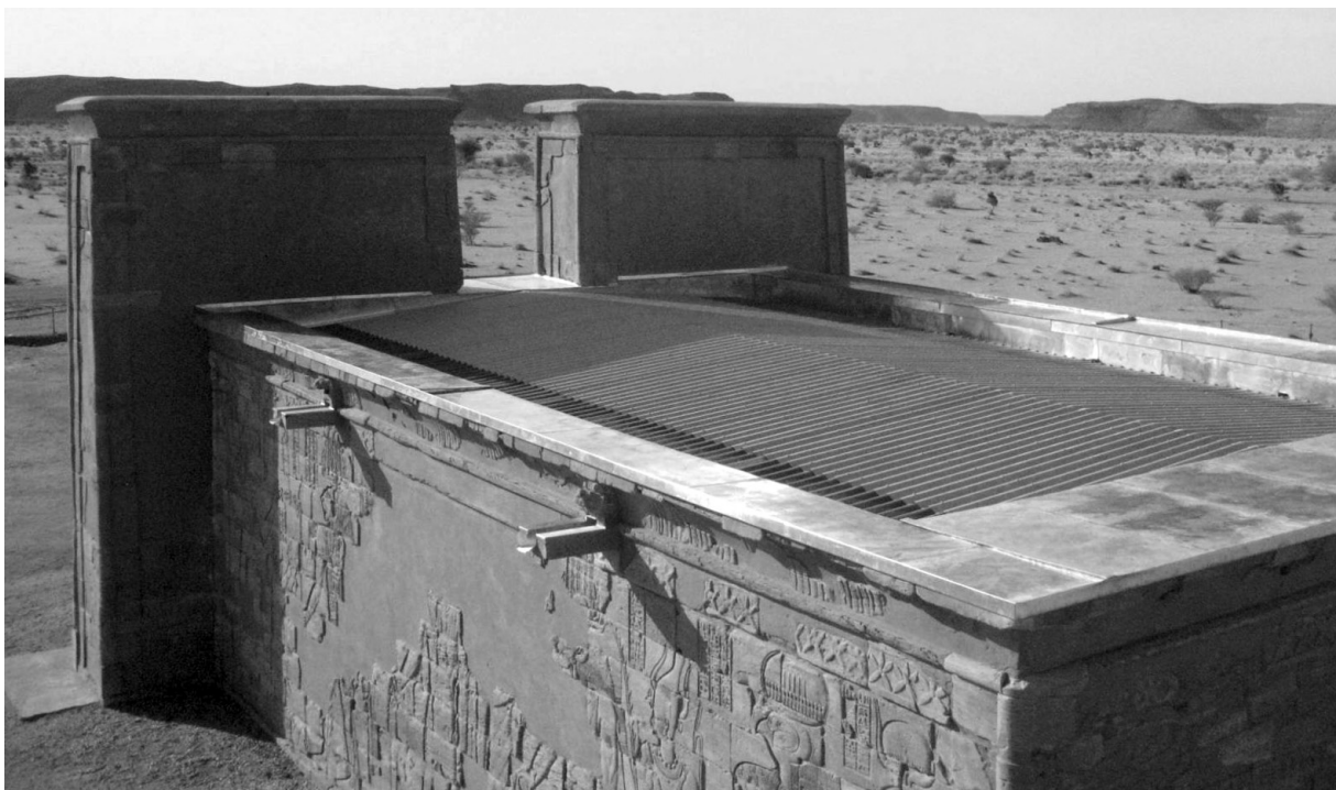
Abb. 7: Blick von oben auf das erneuerte Dach (Foto: Peter Becker)
