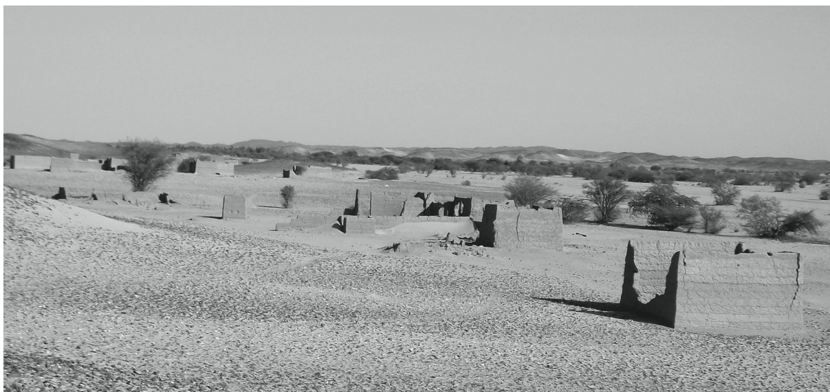
Abb. 3: Die Ruinen eines verlassenen Dorfes nahe Umm Ruweim (Foto: D. Eigner).
