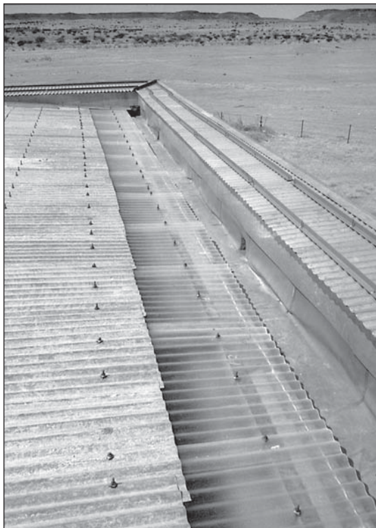
Abb. 12: Das sanierte Dach des Apedemaktempels (Foto: R. Wenig).
