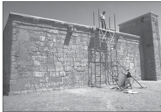
Abb. 3: Gerüst an der Südseite des Apedemaktempels (Foto: R. Wenig).
